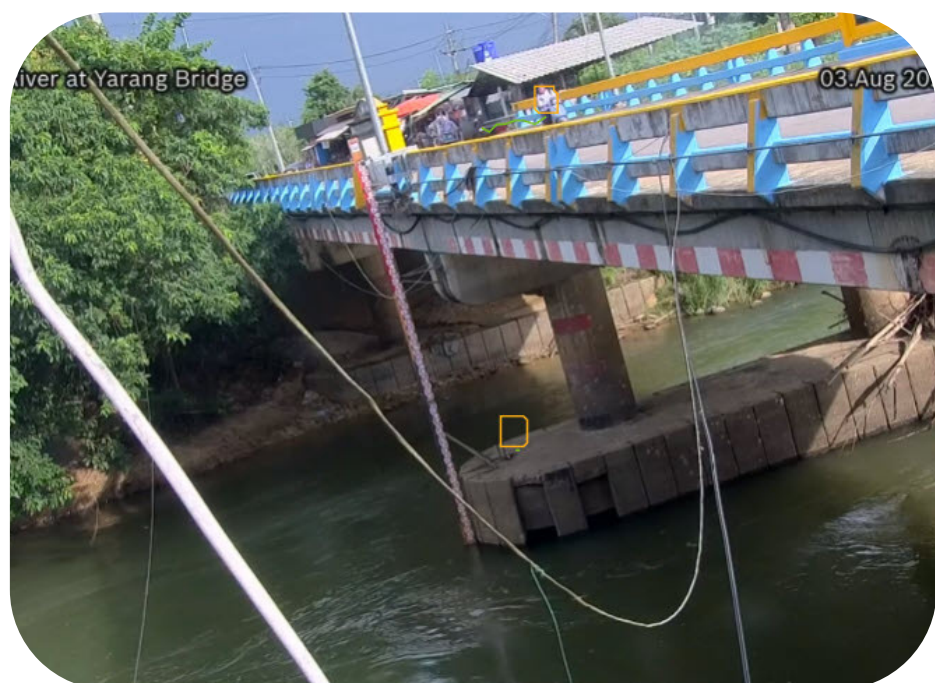
สะพานข้ามแม่น้ำปัตตานี ที่ยะรัง อ.ยะรัง จ.ปัตตานี
